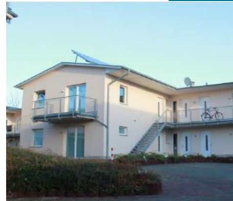
Ein fertiggestelltes Haus mit Mitarbeiterwohnungen
